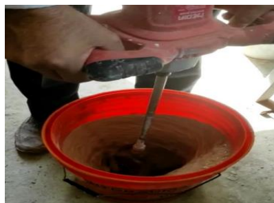
شکل ۵ حل کردن کیک کربناته در آب طرح اختلاط به دو روش دستی و همزن برقی و افزودن به مخلوط
