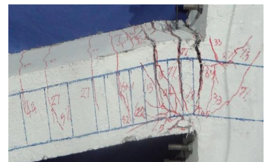
شکل ۱۱ نحوه انهدام تیر RHS1 در انتهای بارگذاری
