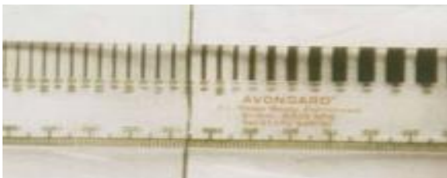
شکل ۴ خط‌کش مدرج اندازه‌گیری عرض ترک‌خوردگی
