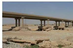
شکل ۲ تخریب ناشی از آبشتستگی در محل پل گلال کنهنک [۲]
