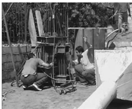
شکل ۲ نصب نیروسنجه بین قاب فلزی
