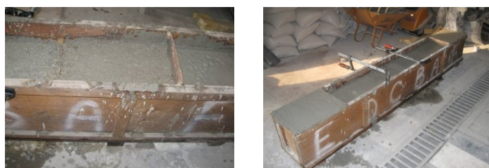
شکل ۳ کلیه قالب‌های پر شده
