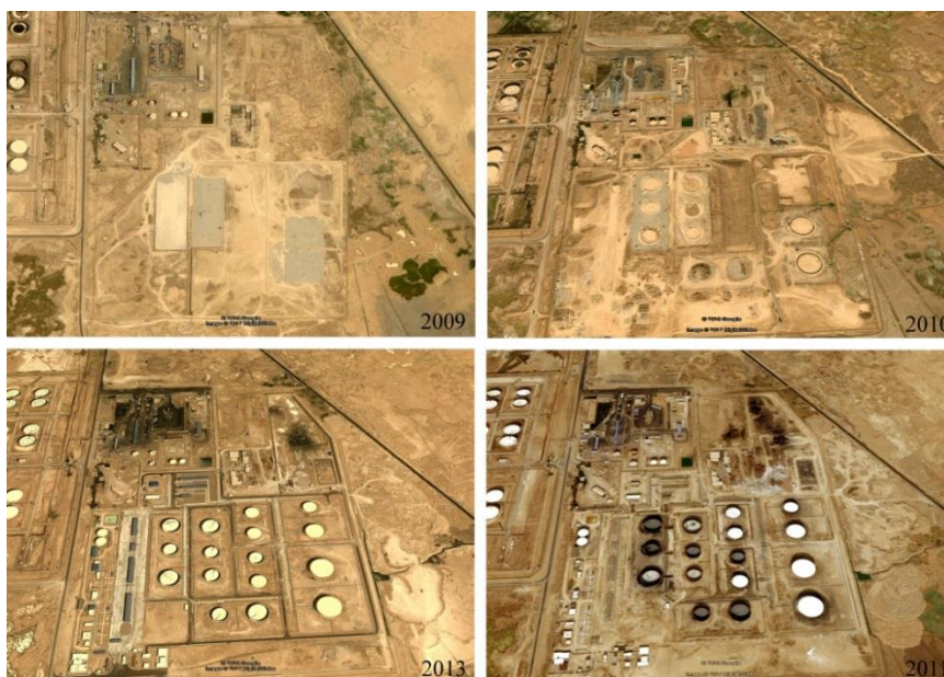
شکل ۲۱ مراحل ساخت مخازن نفت در زمانهای مختلف پروژه
