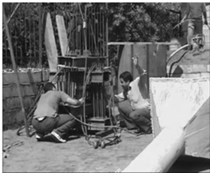
شکل ۲ نصب نیروسنج بین قاب فلزی
