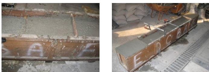
شکل ۳ کلیه قالب‌های پر شده
