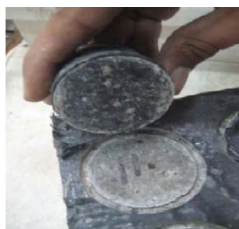
شکل ۸ استوانه‌ی فلزی جدا شده از سطح بتن به‌همراه CFRP
