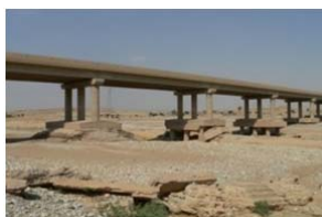
شکل ۲ تخریب ناشی از آبستگي در محل پل گلال
