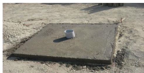
شکل ۲ آماده‌سازی سایت مطالعاتی و نحوه اجرای فونداسیون بتنی مسلح برای اجرای نیل‌ها
