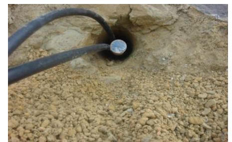
ج) حفاری و میلگردگذاری و نصب لوله‌های تزریق گروت
