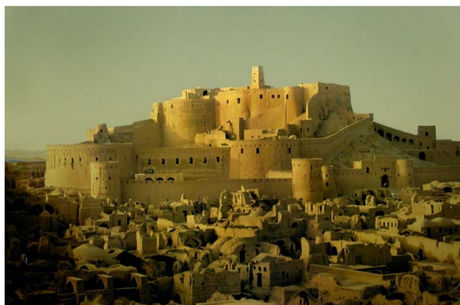
شکل ۱ ارگ بم قبل از زلزله‌ی پنجم دی ۱۳۸۲
