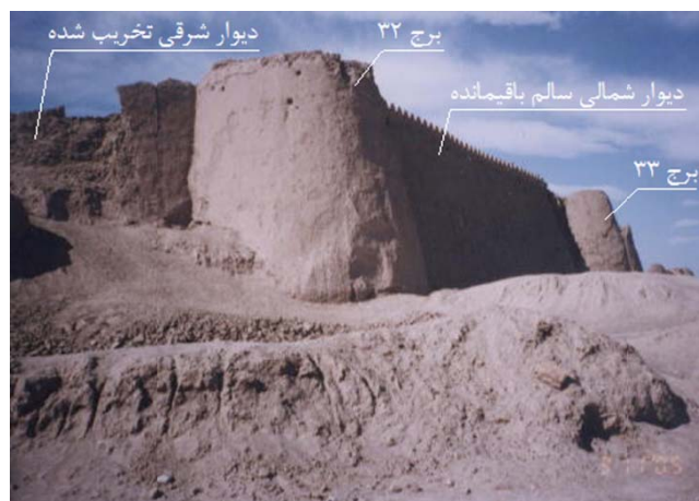
شکل ۴ برج ۳۲ و دیوارهای شرقی و شمالی ارگ بم
