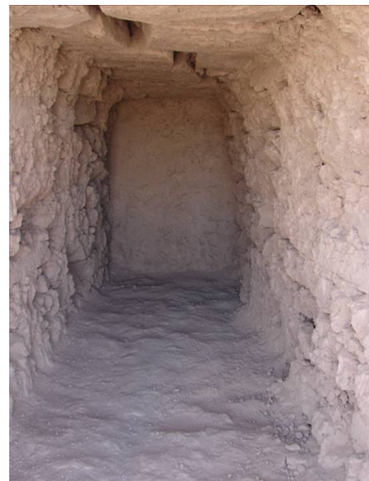
شکل ۱۳ فضای داخلی حفره‌ی ۱ از گمانه‌ی ۴؛ به ترک‌خوردگی ناحیه‌ی بالایی گمانه که تا هسته‌ی برج (در انتهای گمانه) ادامه دارد، توجه شود
