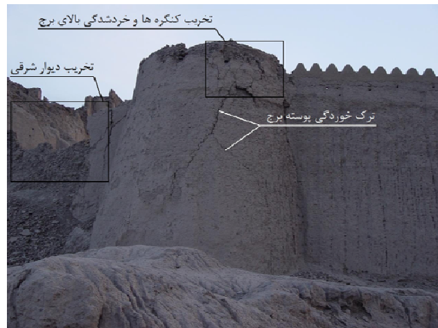
شکل ۳ خسارات وارد به لایه‌ی خارجی برج و دیوار شرقی آن در اثر زلزله
